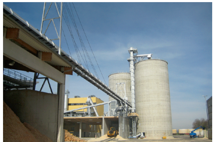
Online-Anbindung vom Säge- zum Pelletswerk mittels Rohrgurtförderer bei Binder Holz in Deutschland
