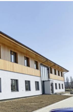
Das neue Bürogebäude von Labe Wood in Steti
