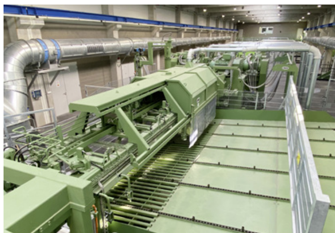
Seitenbrett-Separierer mit Staubschutzhaube, angeschlossen an die Absauganlage von Scheuch
