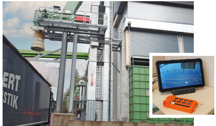
Der Lkw-Fahrer platziert den Rüssel über der Ladefläche – mit Kamera und Tablet (kl. Bild) hat er einen Blick auf den Füllstand und steuert den Verladevorgang
