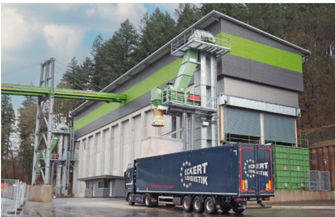
Um das Sägerestholz sauber und trocken zu lagern, realisierte das Sägewerk Streit eine separate Halle samt einer Lkw-Verladestation
