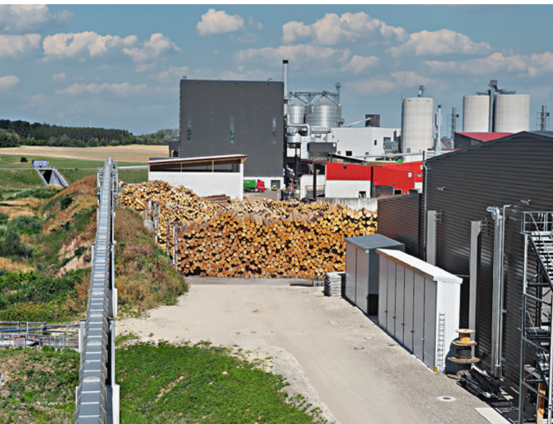
Links der über 700 m lange Rohrgurtförderer, hinten das Heizkraftwerk und daneben die Silos für die fertigen Pellets beziehungsweise das Rohmaterial
