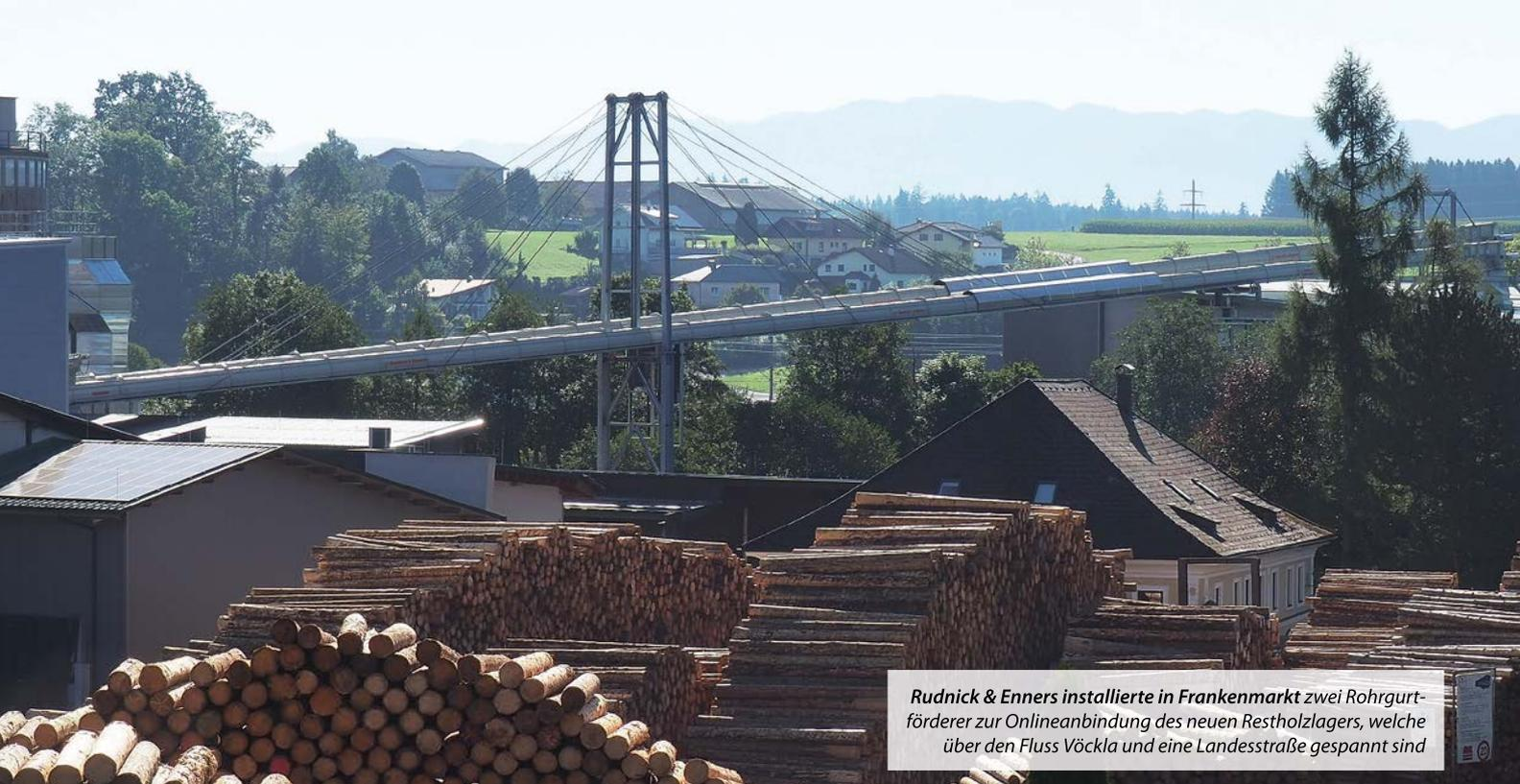
Rudnick & Enners installierte in Frankenmarkt zwei Rohrgürtelförderer zur Onlineanbindung des neuen Restholzlagers, welche über den Fluss Vöckla und eine Landesstraße gespannt sind
