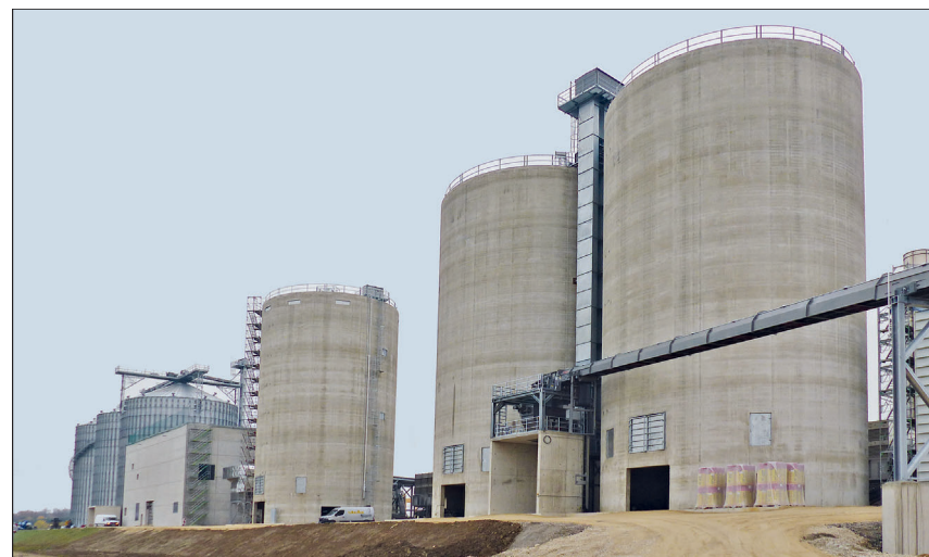
Das Material kommt online aus dem Sägewerk über 700 m lange Rohrgurtförderer und wird zunächst in einem von zwei Nassspänesilos gelagert, links daneben ein Trockenspännsilo, daneben die Pelletproduktion und drei Pelletsilos.
