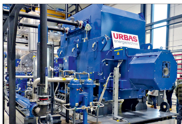
Die Turbine mit Generator erzeugt bis zu 9 MW Strom.
