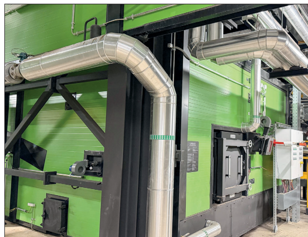
Die KWK-Anlage mit 33,6 MW Feuerungswärmeleistung wurde von Urbas geliefert.
