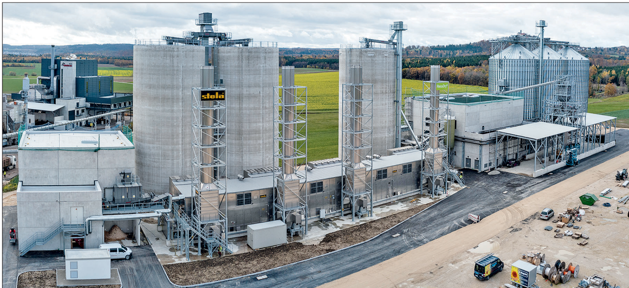
Pelletwerk in der Bauphase, dahinter (links) das neue Holz-Heizkraftwerk
