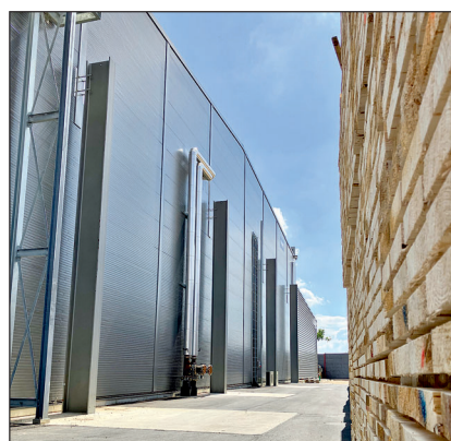
Eine der ersten Maßnahmen in dem Gesamtprojekt war der Bau der Kanaltrockner am Standort Kerkingen. Fotos: Mühlböck
