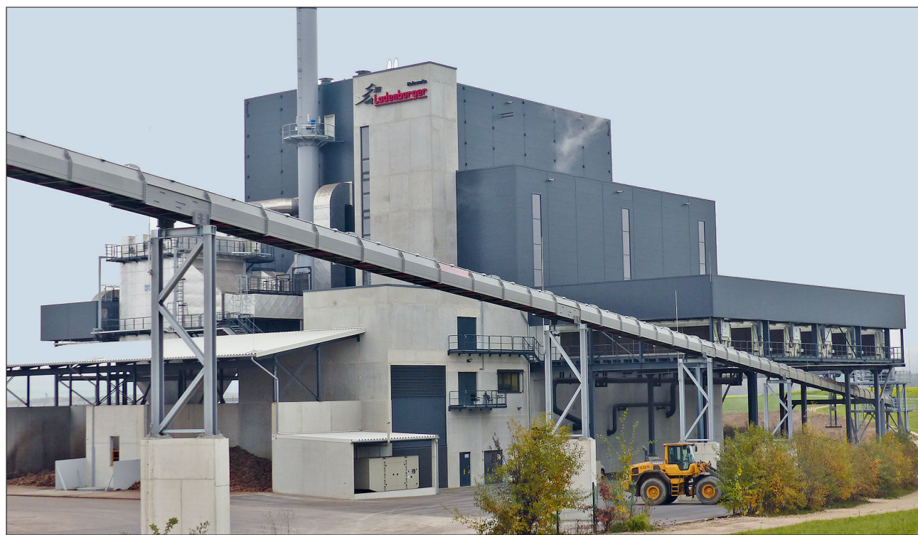
Die energetischen Grundlagen für die Trocknung und das Pelletwerk liefert das neue Heizkraftwerk aus anfallender Rinde.
