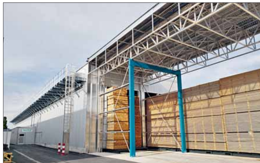
Einer der beiden Anfang August in Wilburgstetten in Betrieb genommenen „Contraflow“-Kanalrockner der Firma Mahild Foto: Mahild
