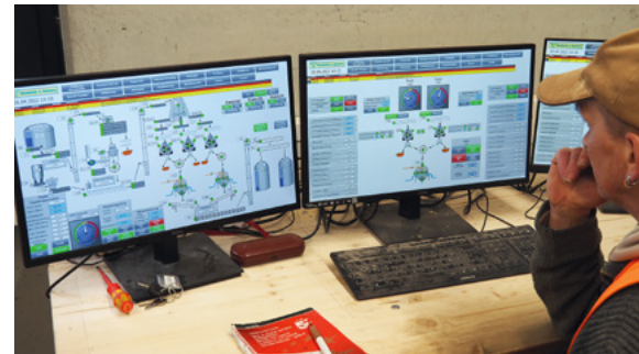
Schaltzentrale: Der Mitarbeiter hat stets Einblick in sämtliche Prozesse der Rudnick & Enners-Anlage – der Alpenroder Maschinenbauer lieferte auch die Visualisierung
