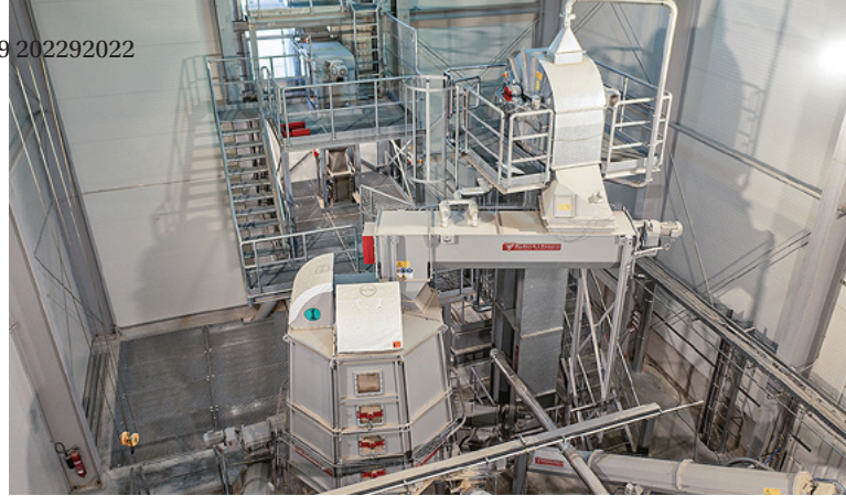
Blick in die Pelletierung mit Reifebunker und Trocken-spanvermahlung
