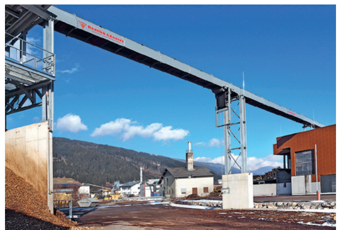
Das optimal zerkleinerte Restholz gelangt über einen Rohrgurtförderer vom Rundholzplatz (re.) in Richtung des Biomasseheizwerks
