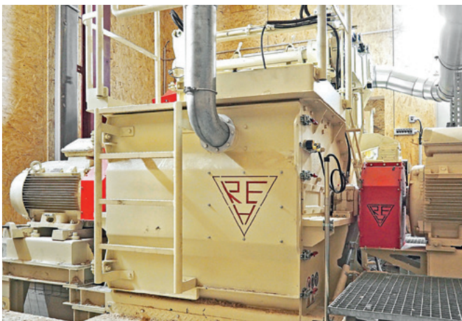
Herzstück der Restholzensorgung im Starkholzsägewerk von Westerwälder Holzwerke: Der Rudnick & Enners-Twin Chipper
