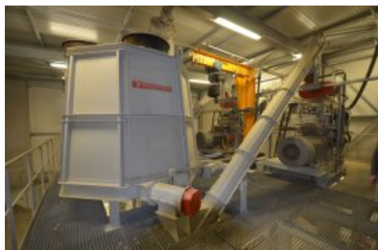
Trémie doseuse Rudnick & Enners pour les presses, photo FD
