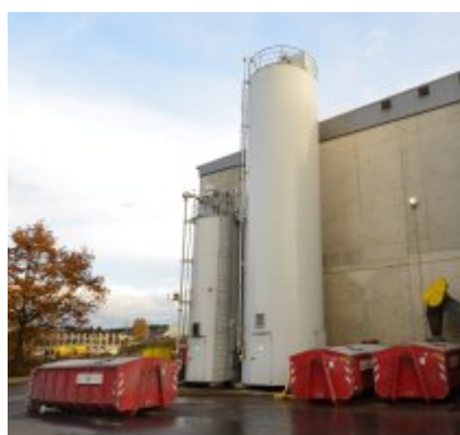
Les silos à chaux et à charbon actif (le petit) pour le traitement des fumées, photo FD
