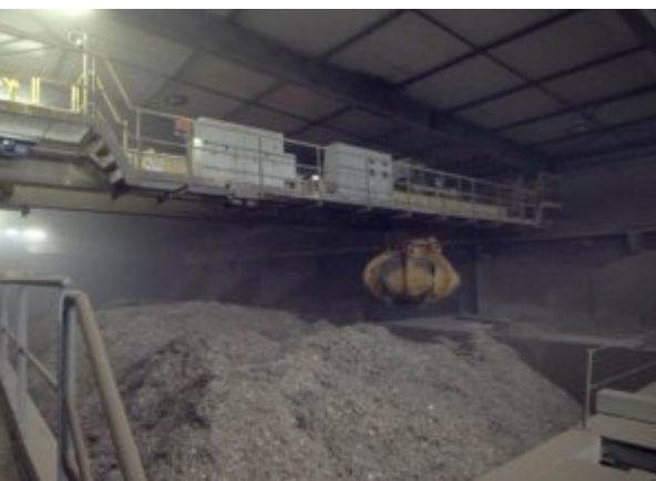
Le silo du combustible bois de rebut, photo Kiowatt
