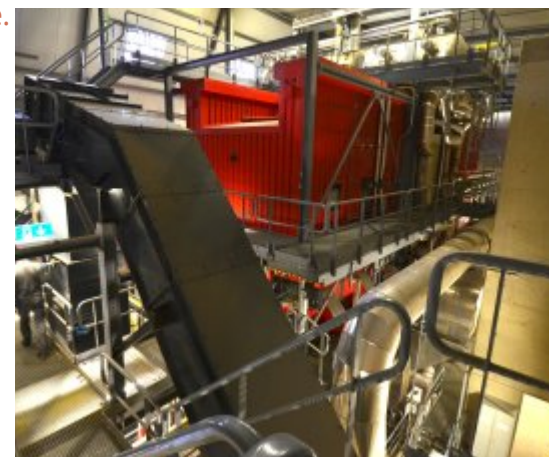
Vue du haut de la chaudière Vyncke de 17 MW, photo FD
