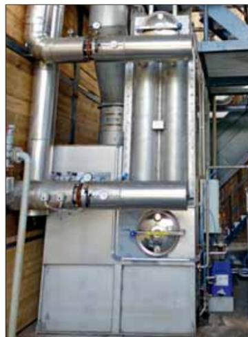
Für maximale Wärmeausbeute sorgt eine Rauchgaskondensationsanlage.
