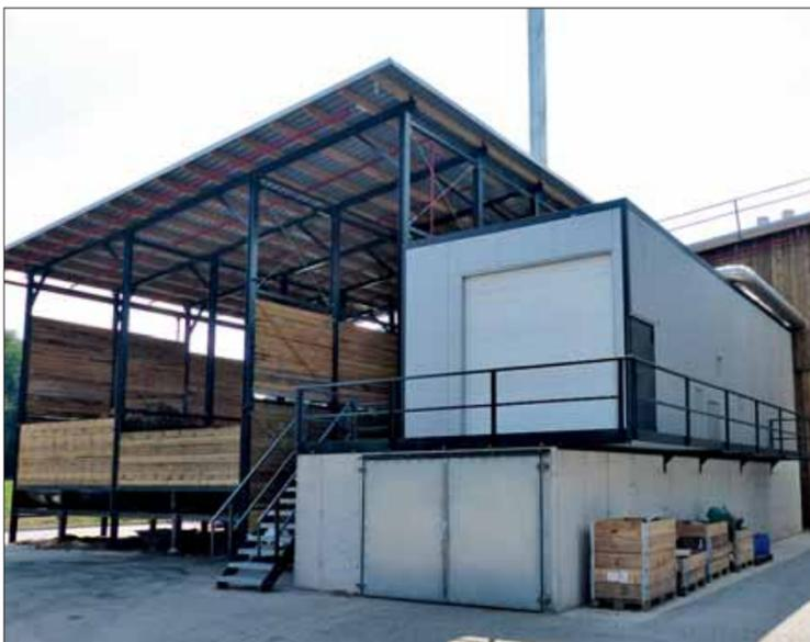
Wie meist bei Polzenith wurde die Kesselanlage komplett im Container vorinstalliert geliefert. Sie steht auf einem Sockel, in dem der Aschecontainer untergebracht ist. Zum Lieferumfang gehörten auch das Brennstoffsilo und der Kamin.
