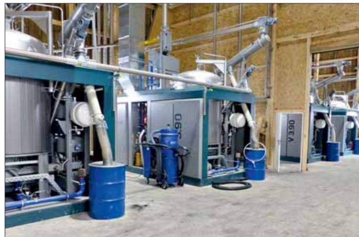
Für die Wärmegrundlast des Pelletwerkes sorgen die vier Burkhardt-Vergaser mit zusammen etwa 1 MW<sub>therm</sub>. Jeder erzeugt zudem 180 kW Strom.
