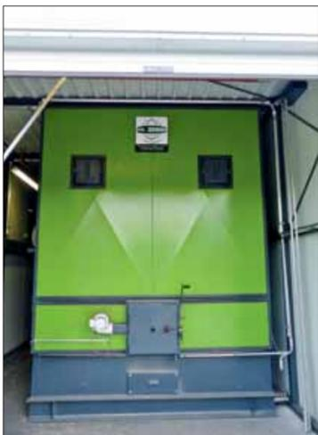
Der Kessel vom Typ „HO/R/ST“ ist für feuchte Brennstoffe ausgelegt.
