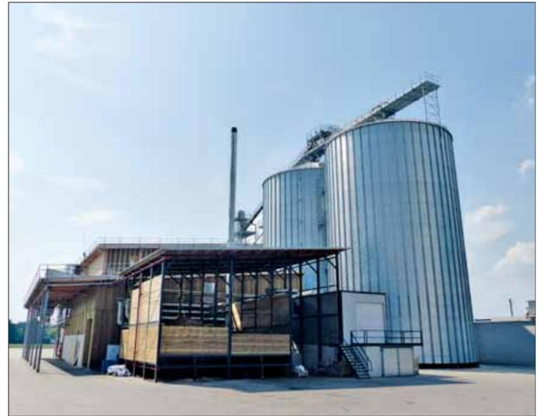
Kompakte Bauweise: neuer Kessel mit Brennstoffbunker, dahinter das Pelletwerk, links ist die Abfüllanlage zu sehen, rechts die Silos für 6 000 t Pellets.
